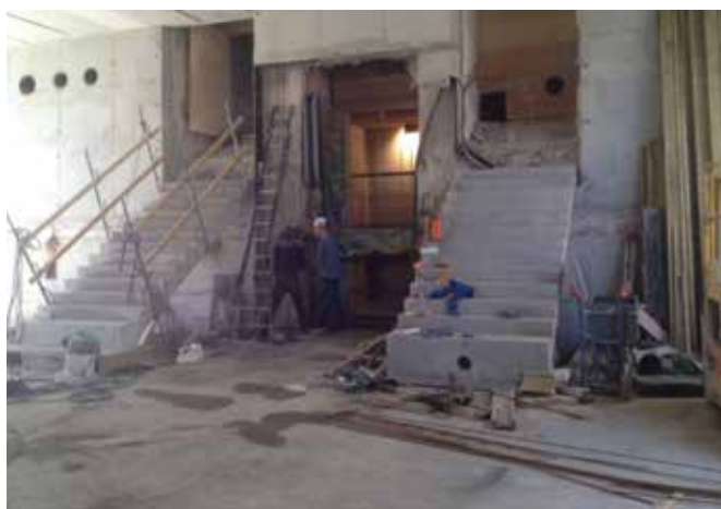
Twee nieuwe trappen aan weerszijden van de liftput.
