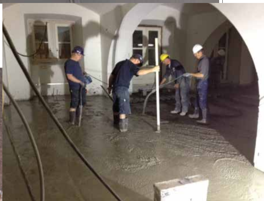
Vrachtwagenladingen beton waren nodig om de vloeren op hoogte te brengen.
