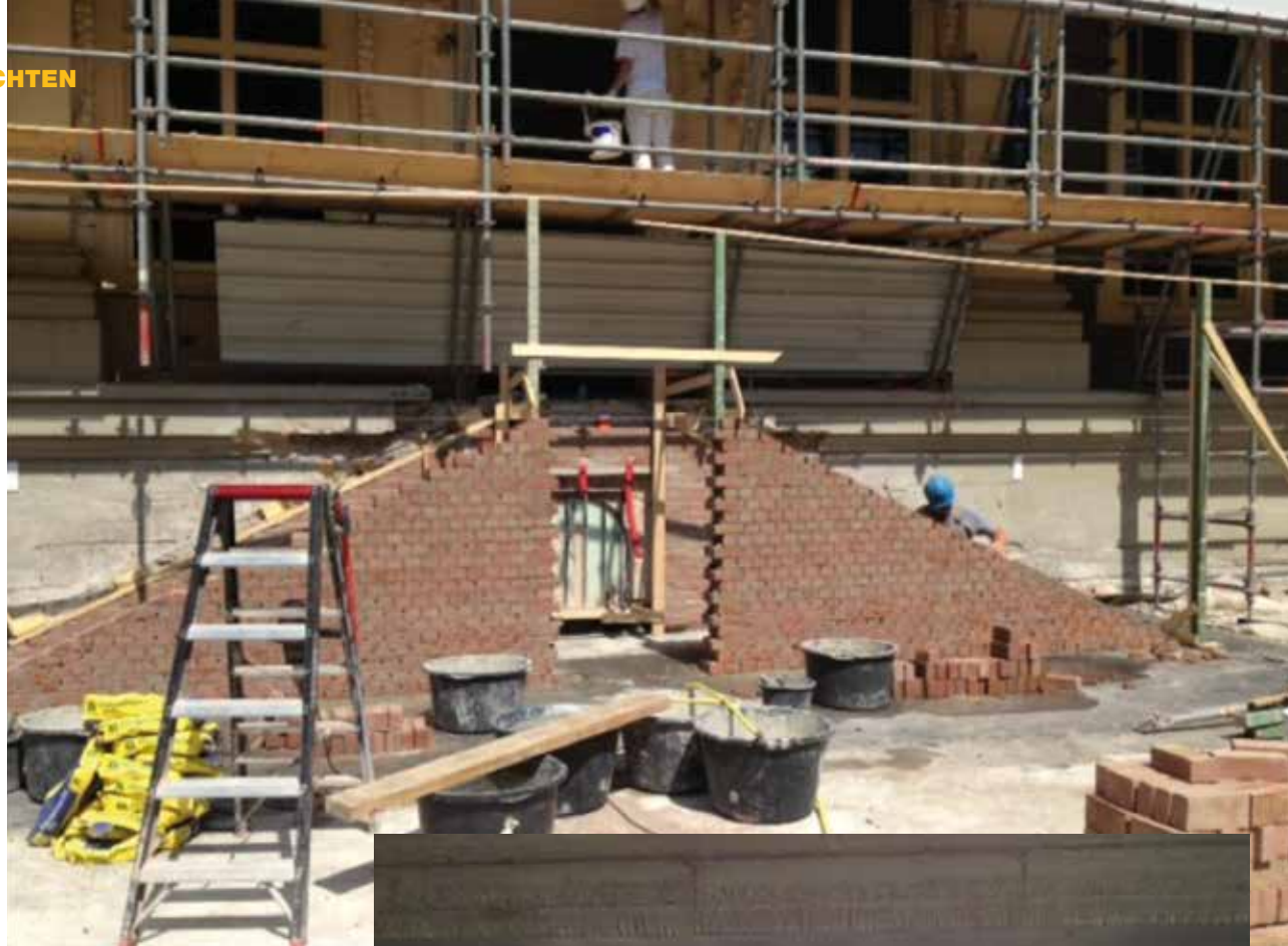
Het bordes naar de voordeur wordt weer opgebouwd.
