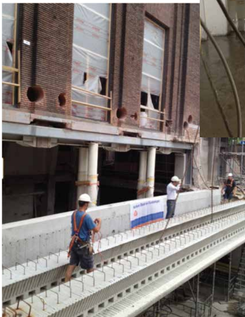
Draagconstructies voor het wegdek Korte Vijverberg worden geplaatst.
