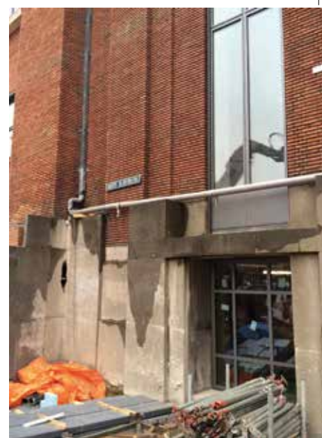
Kozijnen en glas in Plein 26 geplaatst
